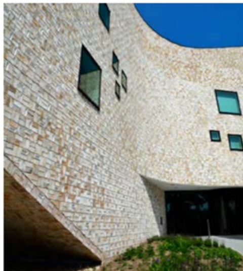
Referentie: Rabobank Sittard door Mecanoo. Doorlopende schil, monolithisch gebouw, vrij geplaatste gevelopeningen, entreepartij in de oksel van het gebouw
