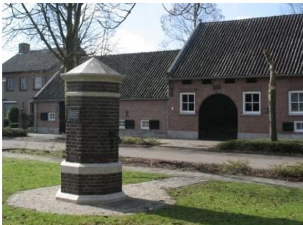
De dorpspomp aan de Lagekerk is een gemeentelijk monument. Deze pomp stond tot 2008 bij Martinetstraat 13, werd in 2009 gerestaureerd en herplaatst op het pleintje hoek LagekerkDerpsestraat (foto: Deurnewiki).
