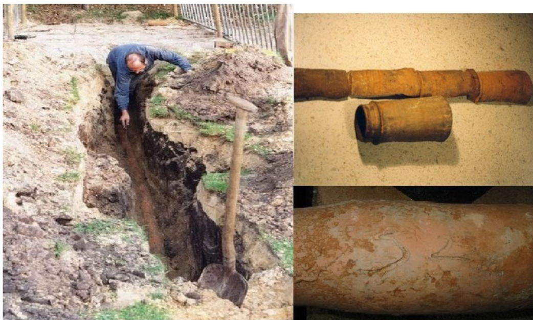
Opgraving van de kannebuizen waterleiding bij de Huub van Doorneweg met rechts details van de genummerde waterleiding (bron: Deurnewiki).
