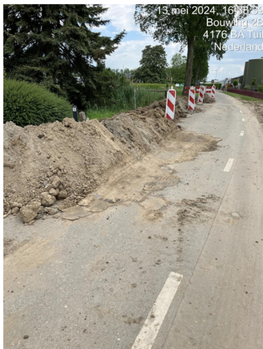
Figuur 14: Nutswerkzaamheden in een asfaltweg
