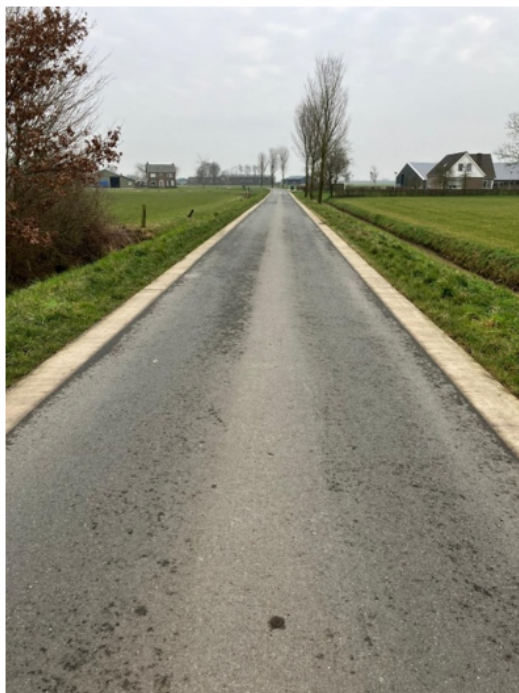
Figuur 9: Een weg met nieuwe bermversteving van cementbeton
