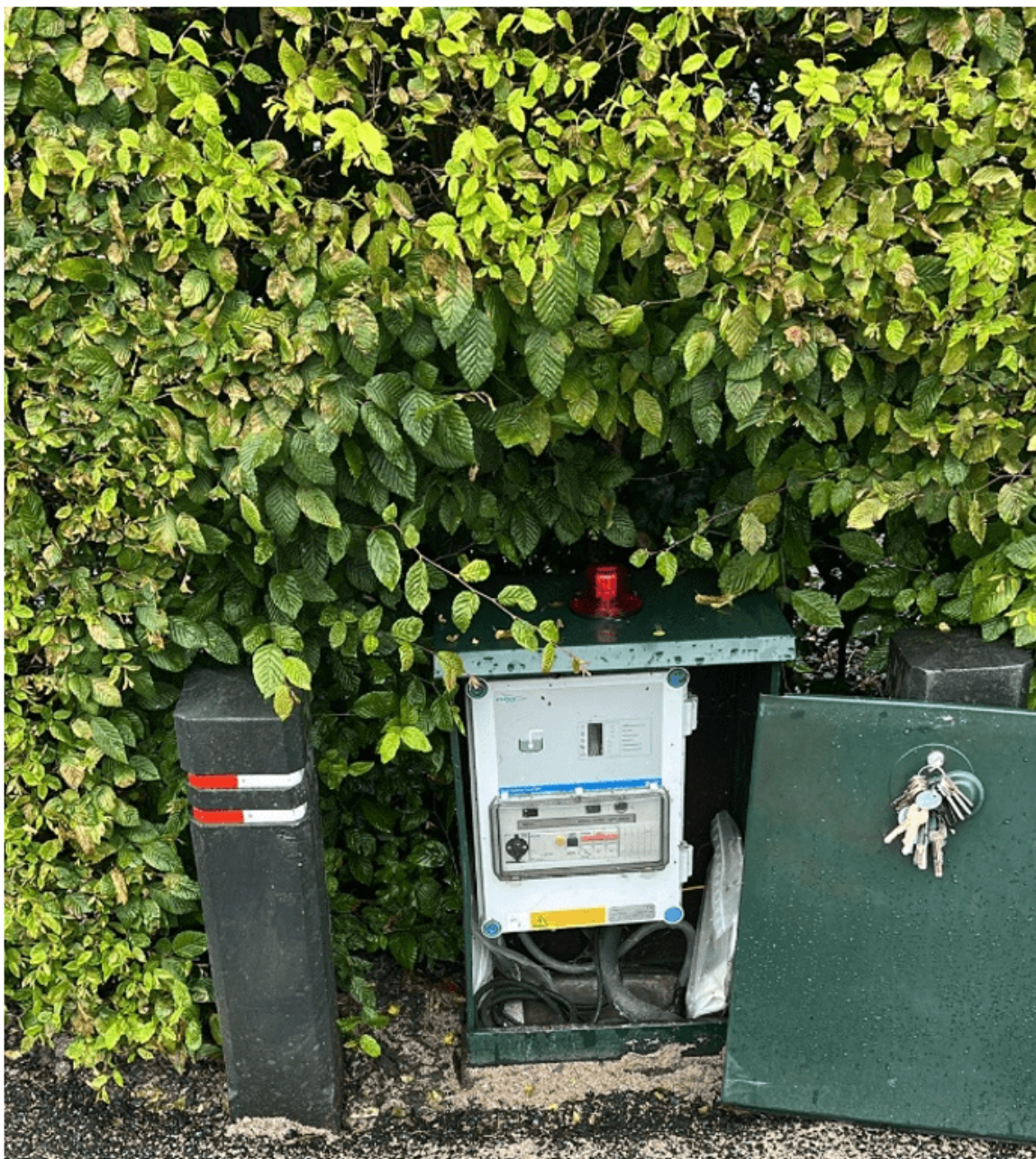
Onderhoud aan de bedieningskast van een mini-gemaal
