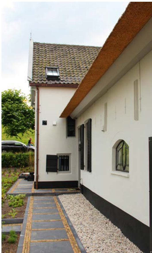
Dwarshuisboerderij Nijverheidsstraat 297 (rijksmonument)
