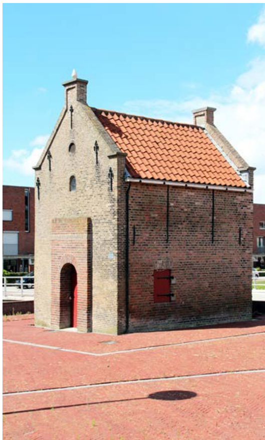
Dief en Duifhuisje aan de Nieuwe Laan 11 (rijksmonument)
