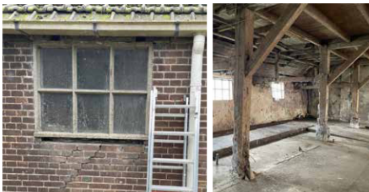
Afbeelding 8. Raamkozijn van stampbeton en gebintenconstructie
