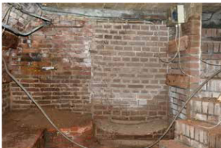
Afbeelding 6. Uitgesleten traptrede van havezate
