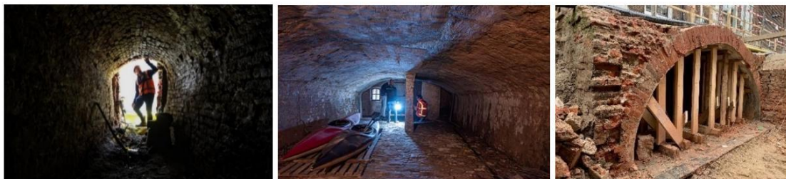
Figuur 7 - een kleine versus een grote kelder en kelder met ondersteuningsconstructie
