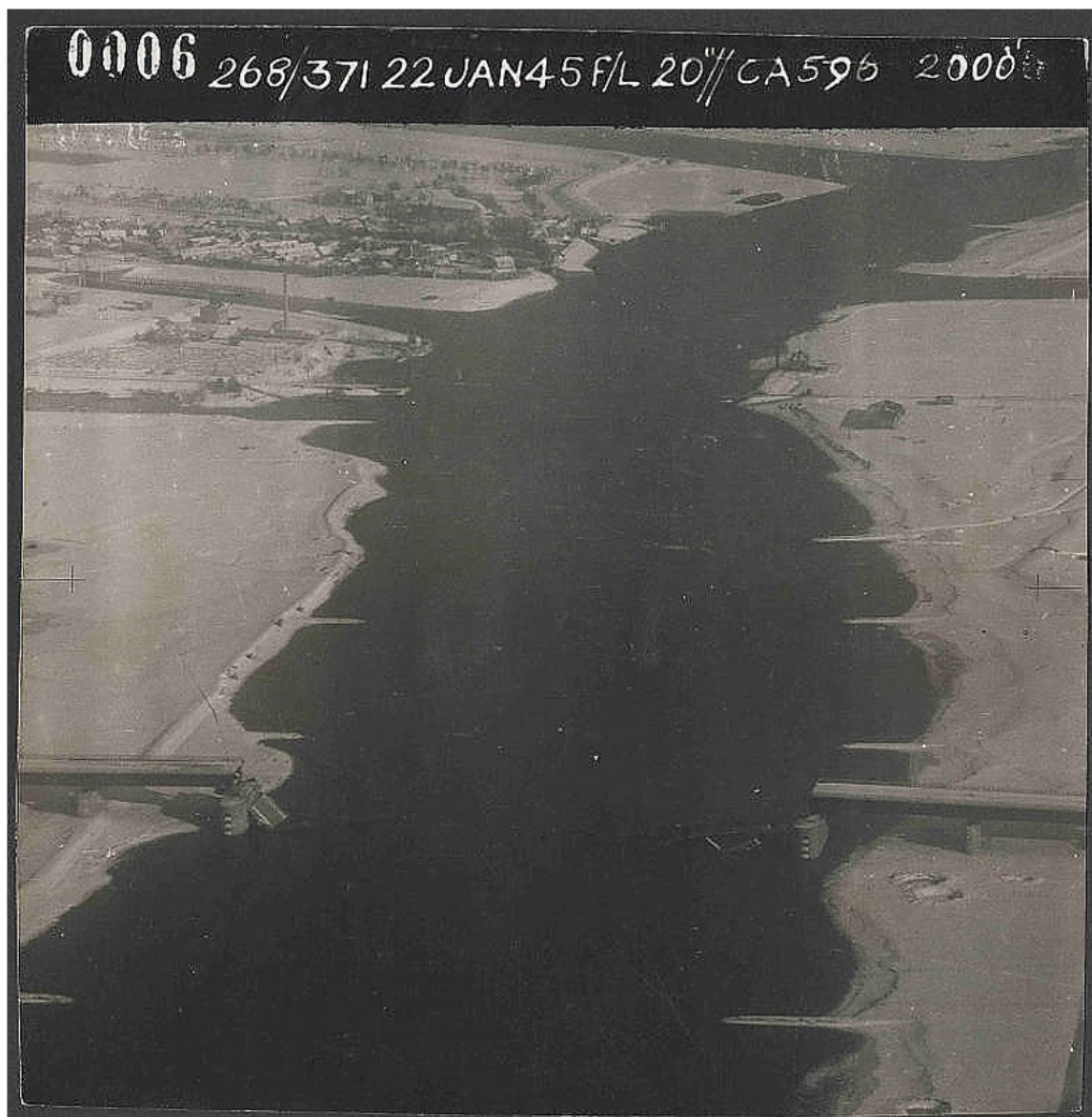
Figuur 7. Op een RAF-luchtfoto van 22 januari 1945 is de schade aan de Lekbrug van Vianen en bomkraters op de oever goed zichtbaar (Wageningen University & Research - Library, Special Collections ; RWK.2-8; RAF 540-01-0006).
