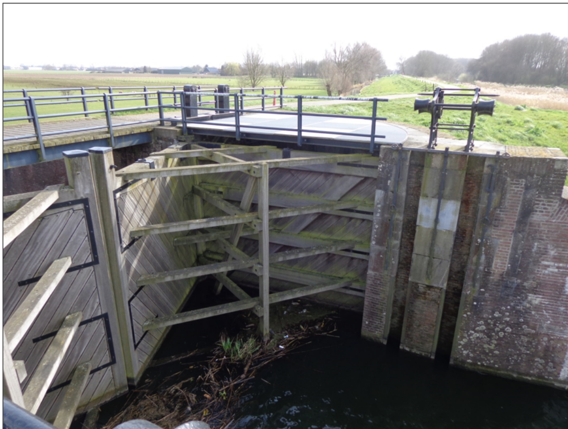
Figuur 5. Een inundatievoorziening: de Papsluis aan de Kildijk te Nieuwendijk. (wikipedia.org).
