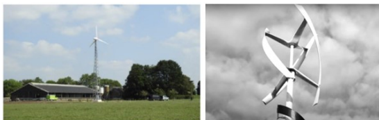
Figuur 2, links: windturbine met een ashoogte van 24 meter met horizontale as (gemeente Bronckhorst), rechts: windturbine met een verticale as
