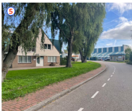
Huidige situatie Omringdijk
