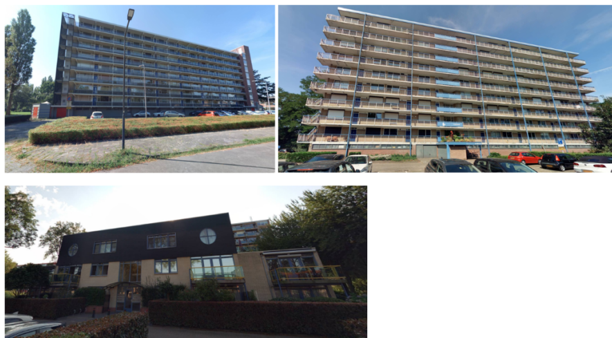
Afbeeldingen 3.7 Linksboven appartementencomplex Kasterleestraat, rechtsboven appartementencomplex Hobokenstraat, Onder appartementencomplex Zomergemstraat (bron: Geoweb)
