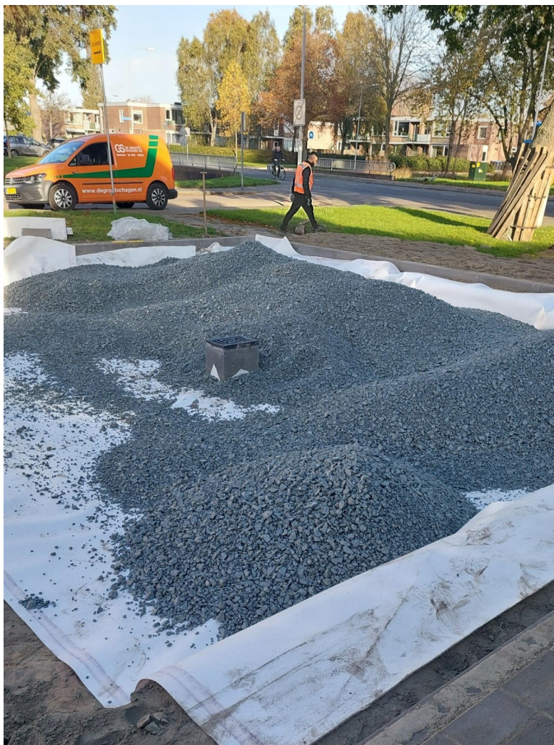
Aanleg waterbergende wegfundering Da Costastraat
