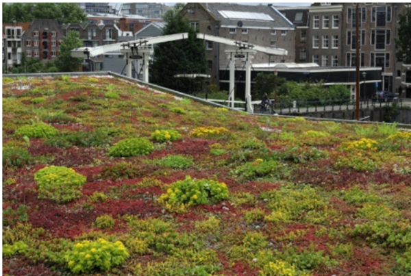
Afbeelding 27: Een groen dak vergroot de woonkwaliteit van woningen die op het dakvlak zijn georiënteerd en draagt bij aan de klimaatadaptatie.
