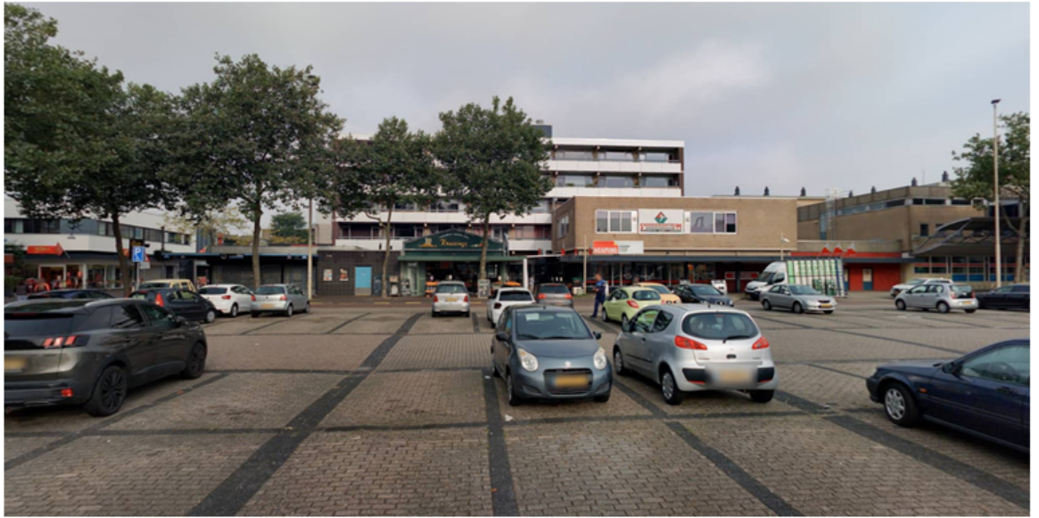
Afbeelding 2: Noordelijke gevelwand Burgemeester Kuperusplein
