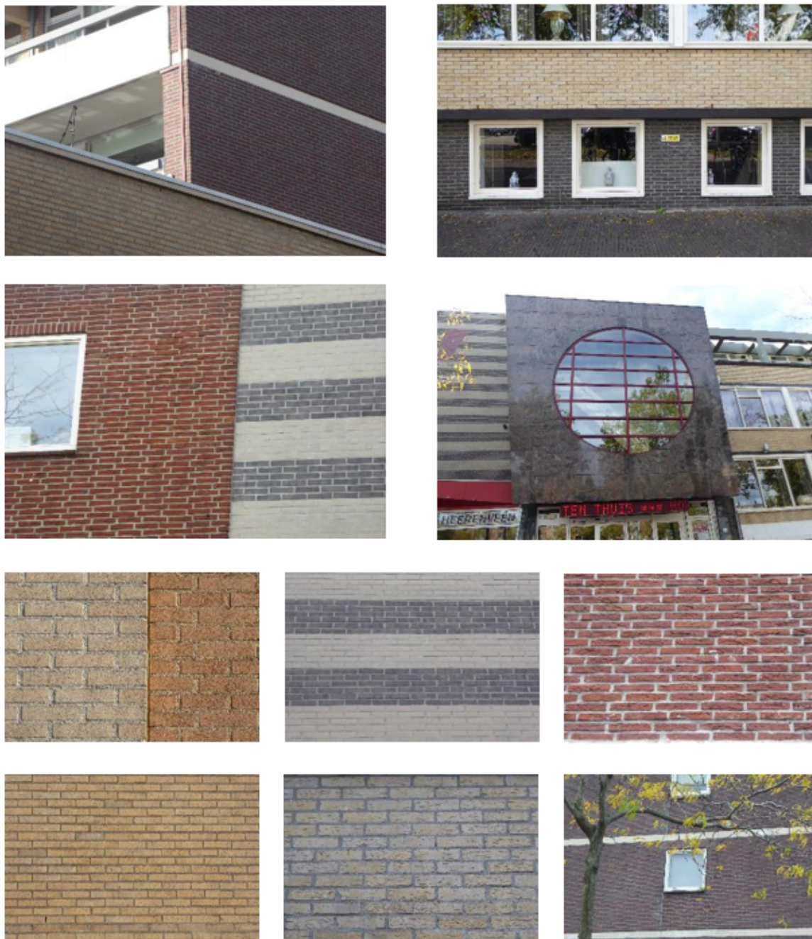
Afbeelding 5: De gevels rondom het Burgemeester Kuperusplein worden gekenmerkt door een grote mate van diversiteit als het gaat om kleur- en materiaalgebruik. De diversiteit is vooral te zien in de westelijke gevelwand. De oostelijke en noordelijke gevelwand zijn hoofdzakelijk uit een gele baksteen opgetrokken
