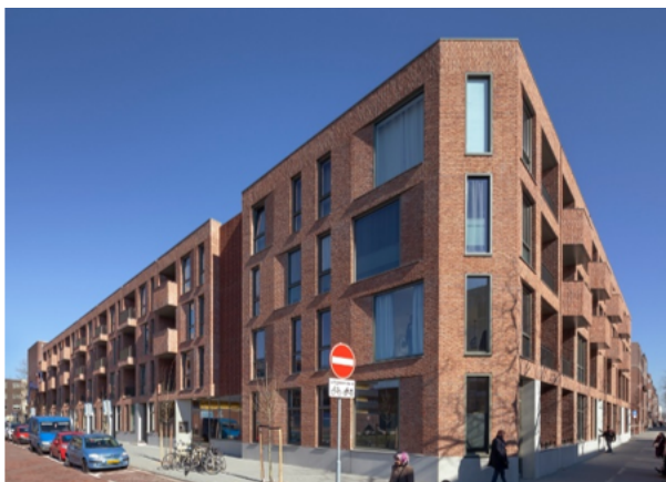
Afbeelding 19: Het gebouw kent een sterke overhoekse oriëntatie. de vormgeving van deze hoek draagt bij aan de interactie vanuit de Sieversstraat richting het Burgemeester Kuperusplein.
