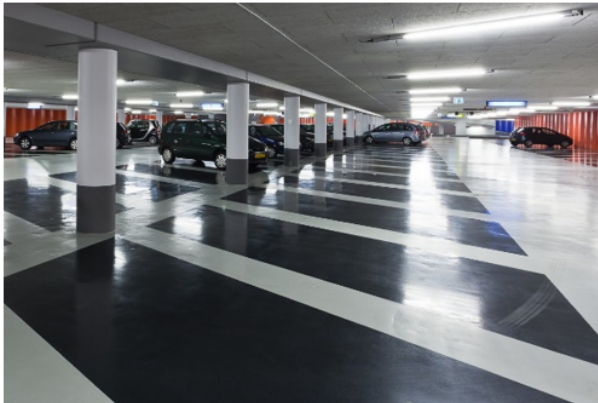
Afbeelding 17: Parkeergarage in Delft. De draagconstructie van de garage werkt niet belemmerd bij het inrijden van een parkeervak.
