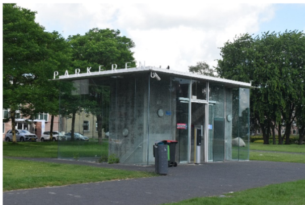
Afbeelding 8: Parkeergarage Geerts Willigenplein in Heerenveen. Stijpunt kent een hoge mate van transparantie.
