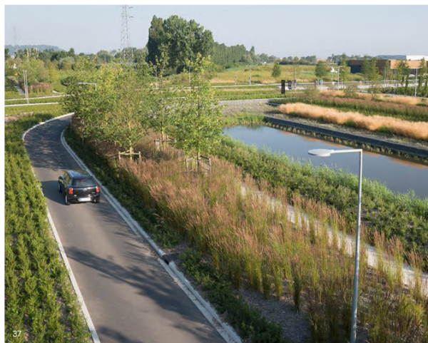
Groene berm scheidt wegprofiel en fiets/wandelpad
