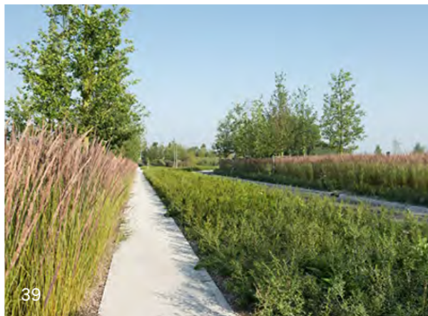
Fietsprofielen gemaakt van hergebruikte betonplaten
