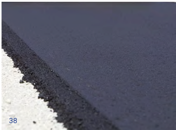
Wegprofiel van waterdoorlatend bio-asfalt
