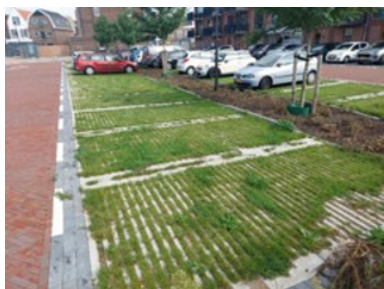
Slim gebruik maken van compacte woonstraten door open waterafvoer en waterdoorlatende bestrating
