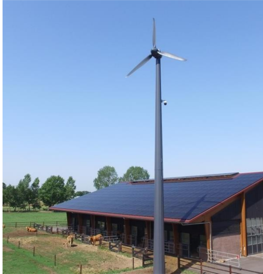
Figuur 2.4: Kleine windturbine in het landelijk gebied met een erg kleine rotor in verhouding tot de masthoogte
