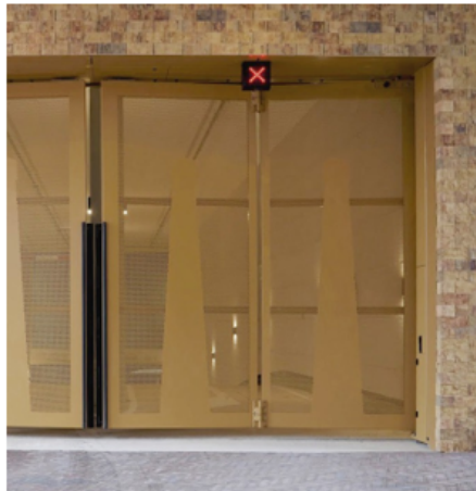
Verdiept gelegen entree autoparkeervoorziening met geperforeerde speedgates.
