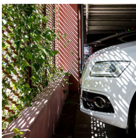
Autoparkeervoorziening voorzien van groen, daglicht en natuurlijke ventilatie, Park 'n' Play, JAJA Architects, Kopenhagen
