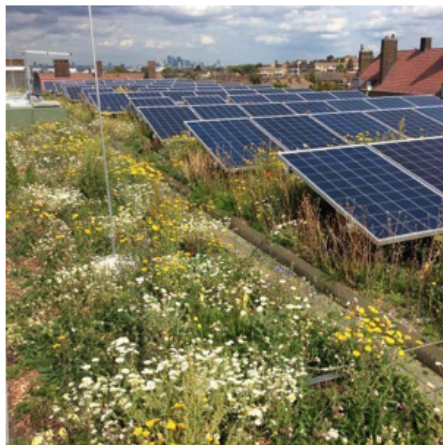
PV panelen worden zorgvuldig geïntegreerd Clapham Park, The Bauder BioSOLAR system, London
