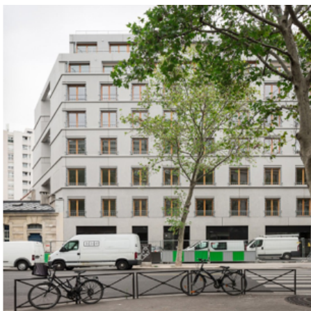
Elegante uitstraling van gevels aan de levensader Apartment Building & Nursery School, Lacroix Chessex, Parijs
