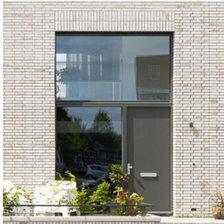
Gevelopening afgewerkt met een rollaag, Janninkkwartier, Zecc, Enschede,
