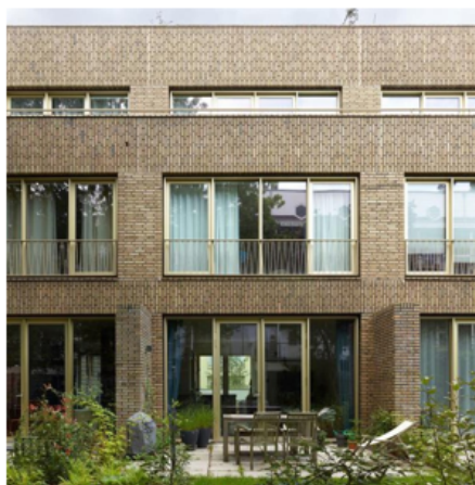
Plint met woonprogramma uitgevoerd in dezelfde architectonische als verdiepingen daarboven Spaardammerhart, Korth Tielens Architecten/ Marcel Lok Architect, Amsterdam
