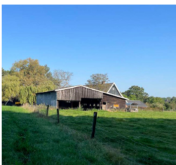
Zomerbeeld. Te slopen oude kapschuur en markant de treurwilg op het erf. Langs Bruggemansweg staan zomereiken.
