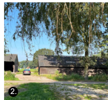
Te slopen schuur westzijde erf en Bruggemansweg: 304 m 2 .
