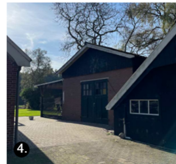
Te slopen aanbouw bij houten schuur aan wegzijde: 100 m 2 . Dit oppervlak wordt niet meegerekend bij de totaal te slopen m 2 noodzakelijk in kader van Rood voor Rood.
