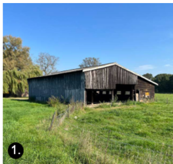
Te slopen houten schuur op erf: 288 m 2 .
