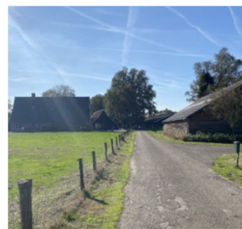
Via de brug Borne beek wordt het erf ontsloten. De Bruggemansweg is tot aan het erf verhard met asfalt zandweg.
