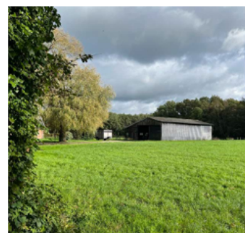
Te slopen houten schuur op erf.
