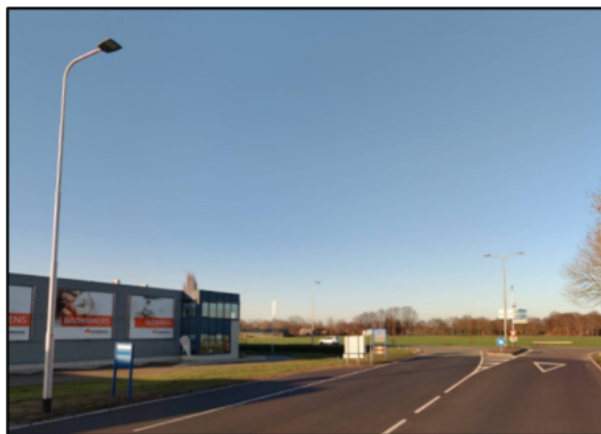
Foto: 8 meter hoge mast met uithouder en led armatuur.
