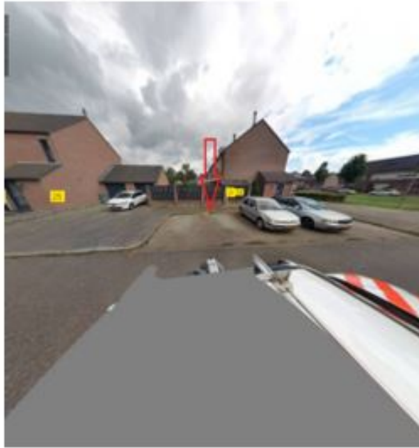
Weert 6005 KS Kwartelstraat 27 0988-3454
