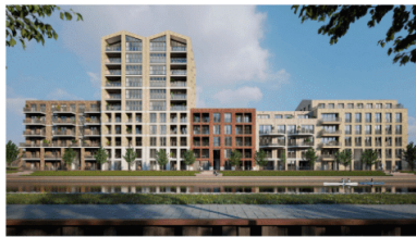
Eenvoudige vormtaal van de gebouwen
