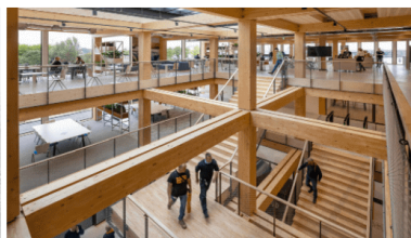
De onderbouw als driedimensionaal, modulairst raster
