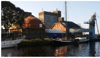
Het EMG-gebouw - iconisch herkenningspunt langs de kade
