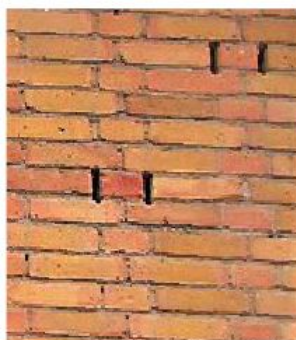
Open stootvoeg voor vleermuizen
