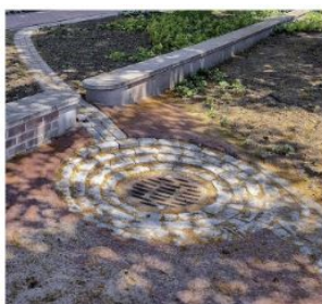
De waterkolk: zichtbare waterloop
