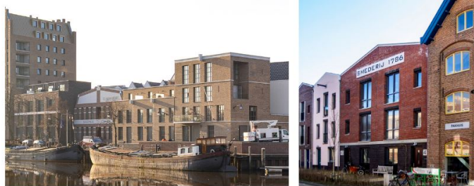
Bouwmassa Geschakelde industriële panden aan de kadewand
