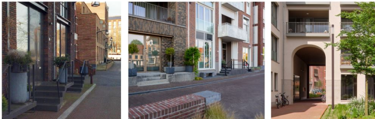
Overgangen privé-openbaar Verschieden vormgegeven overgangszones voor een menselijke maat. De poort geeft vorm aan de schaalsprong tussen de bouwmassa's
