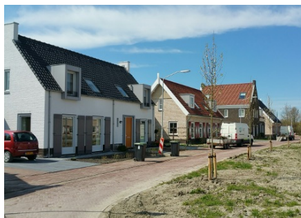
Nieuwbouw aan de Schulenburg in Oostkapelle
