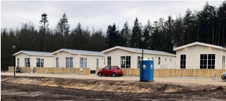
Voorbeeld nieuwe woonwagenlocatie met vier huurstandplaatsen en huurwoonwagens
