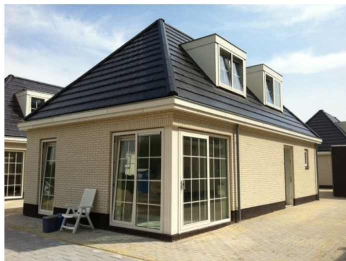
(Foto: Stenen woonwagengalets in gemeente Nijmegen, locatie Teersdijk)
