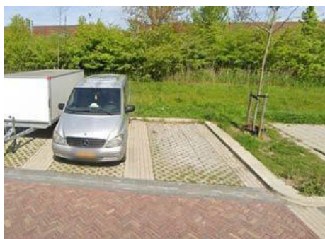
grasbeton in parkeervakken
