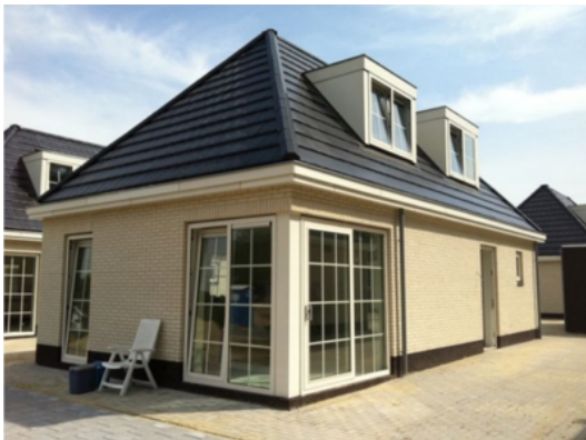
Stenen woonwagena chalets in gemeente Nijmegen, locatie Teersdijk
