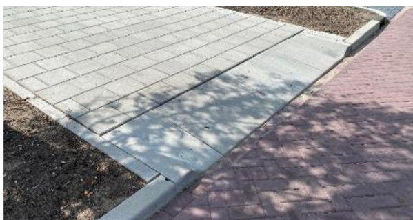
Figuur 8 inritconstructie door groenvak. Locatie: Balkweiterhoek Zwaagdijk-West
