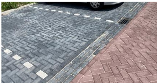
Figuur 11, haaks parkeervak betonstraatsteen antraciet, elleboogverband, markering ingestraat
