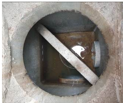
Overstortmuur in rioolput
