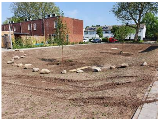
Wadi in aanleg
