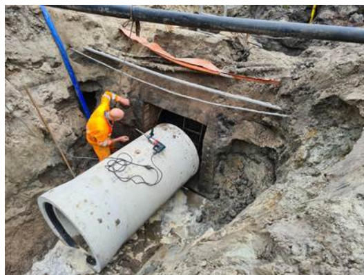
Rioolvervanging Nobellaan
