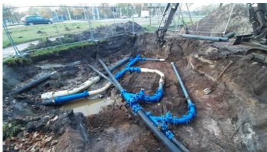
Aansluiting persleidingen
