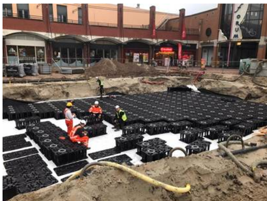
Aanleg stormharvester op Koopmansplein
