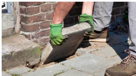
Vergroenen tuin door verwijderen van verharding
