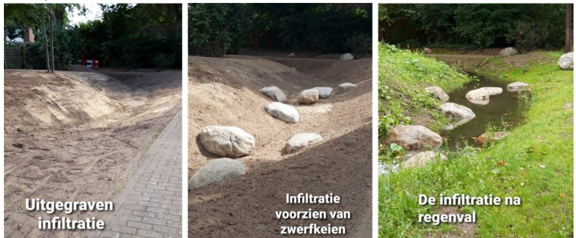
Figuur 2.4: Werkzaamheden van de wadi
