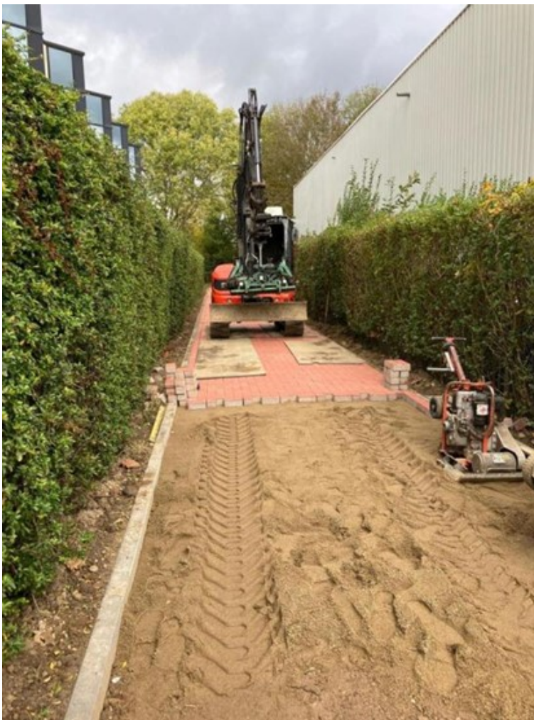
Figuur 6: Aanleg fietspad Weerterkerkweg.
