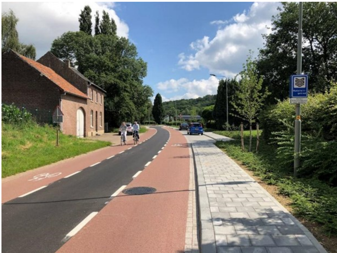
Figuur 14: Humcoverstraat (bron: Fietzersbond).
