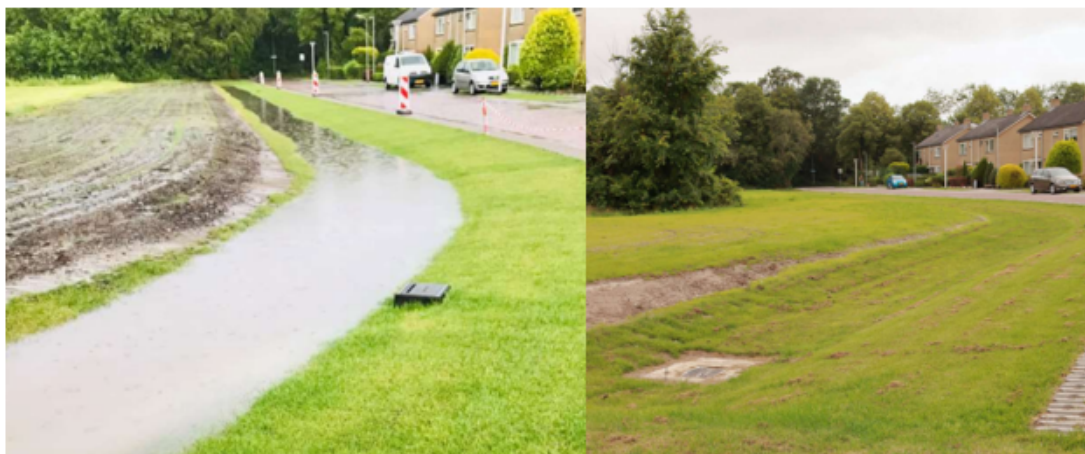
Figuur 8-2: Wadi Prinses Marijkestraat in Wieringerwerf in gemeente Hollands Kroon. Links is bij nat weer en rechts is bij droog weer
