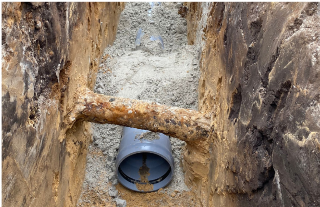
Figuur 8-4: Aanleg hemelwaterriolering Westerlaan Westerland
