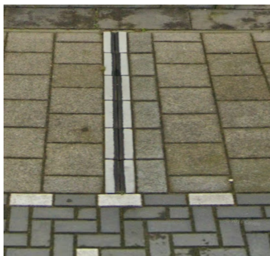
Kabelgoot in Etten-Leur
