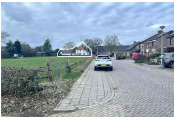
Zicht op de Aaj Weem via paardenweide en zicht op de langgevelboerderij
