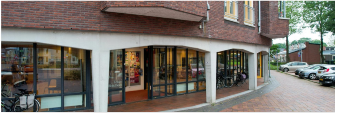
Het nieuwe inlooppunt in de Forumbibliotheek in Ten Boer
