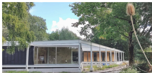
Circulair paviljoen Milieu Educatie Centrum in aanbouw
