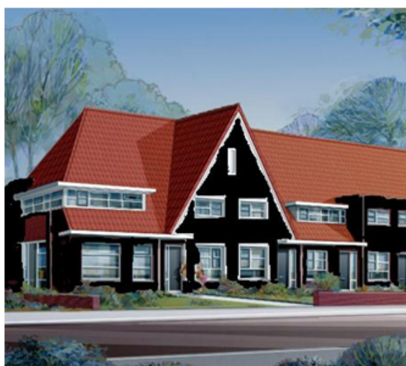
Figuur 3 dakconstructie begint onder ramen 2 e bouwlaag
