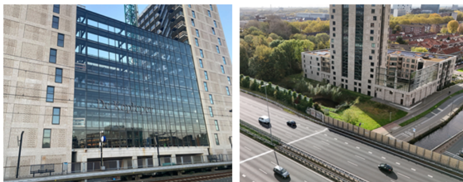
Figuur 10 Twee voorbeelden van een geluidscherm als onderdeel van het gebouw waarmee een geluidluwe zijde wordt gecreëerd. Links Gouda station en rechts A13 Delft.
