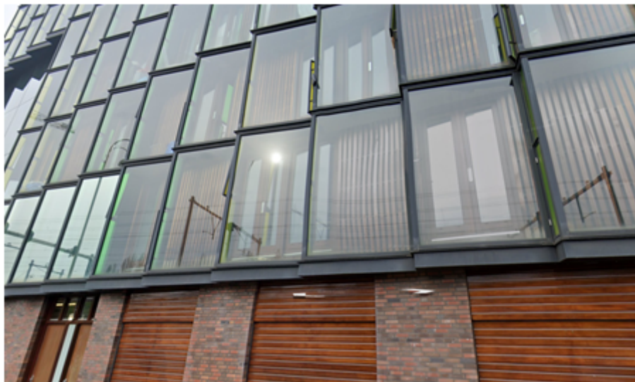
Figuur 7 Voorbeeld van een vliesgevel waarmee het geluid op uitwendige scheidingsconstructie wordt verminderd.
