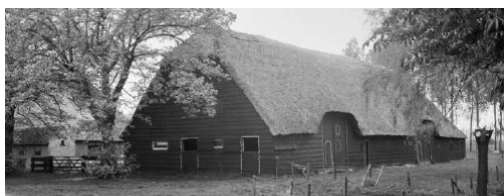
schuur - Westdorpe lage gevels, rieten dak
