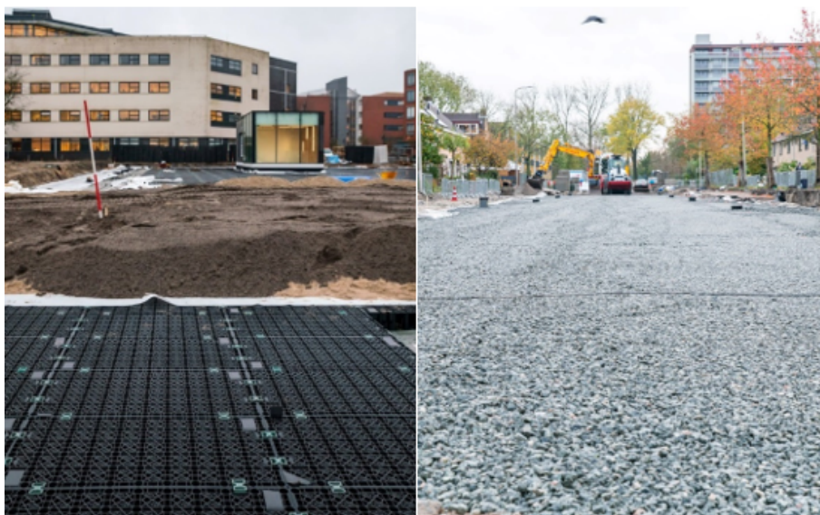
Afbeelding: (Links) Waterbergingskratten onder groen stadhuis plein. Het regenwater in de berging wordt benut voor het groen op het plein. (Rechts) Aanleg waterbergende fundering onder de rijbaan. In natte tijden een buffer die in droge tijden ingezet kan worden voor groen.
