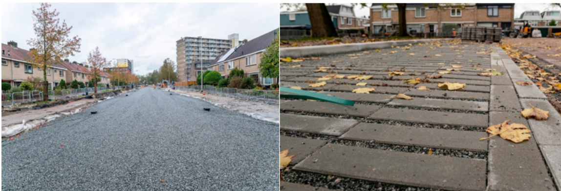
(Links) Aanleg waterbergende weg Wheermolen -Oost. (Rechts) Waterbergende parkeerplaatsen Overwhere -Zuid
