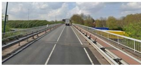
Huidige situatie viaduct over A27
