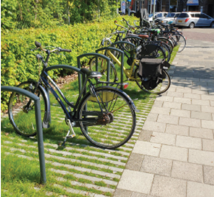
Fietsparkeren op (half)open verharding
