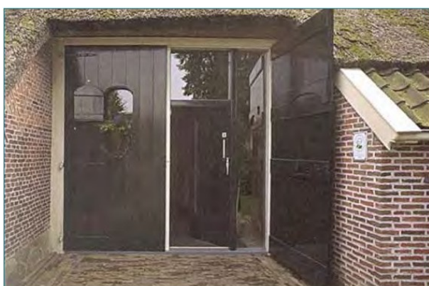
Verbouw van het oorspronkelijke hoofdgebouw
