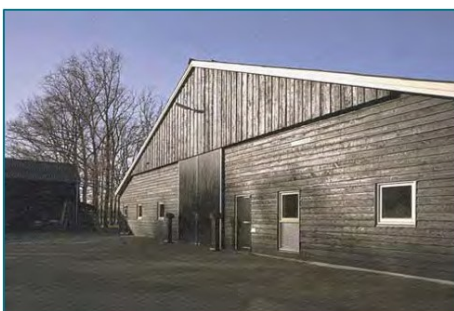
Zadeldak, topgevel met hout bekleed
