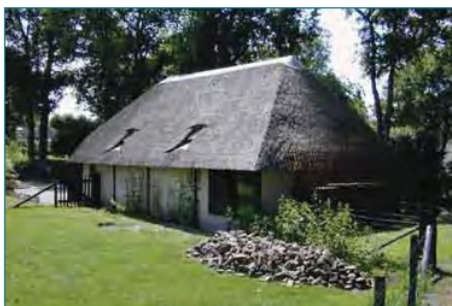
Foto midden: Verbouw van schuur tot restaurant/ partycentrum Foto's rechts: Verbouw van schuur tot kantoor.
