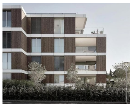
Horizontale geleding, terugspringing bovenste laag
