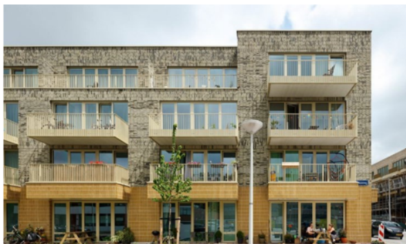
Afwijkende plint, terugspringing bovenste laag
