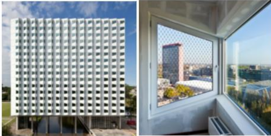
Figuur 6 Zaagtandgevel bij een geluidsbelasting van de zijkant.
