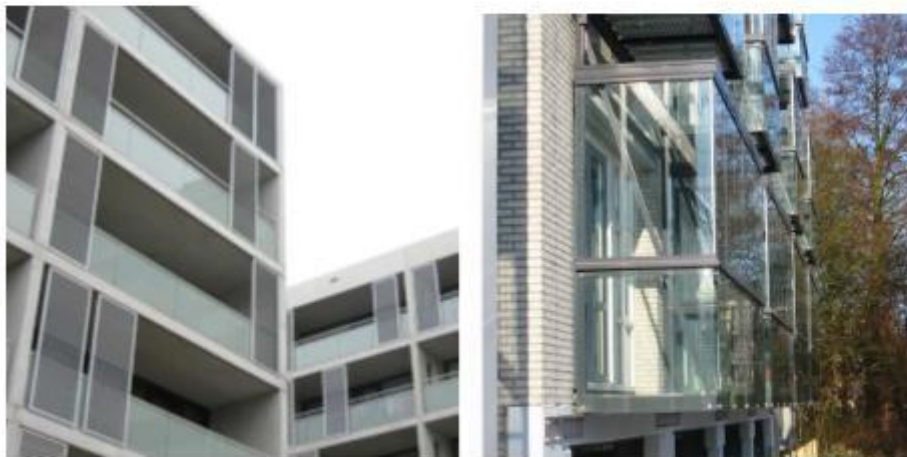
Figuur 8 Afscherming met gevelementen (links) met een loggia (rechts)
