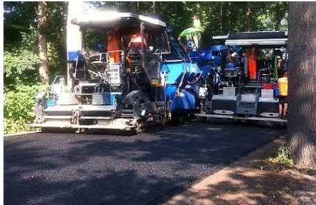
Aanleg stil asfalt N319
