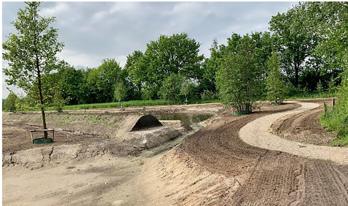
Nieuwe verwijzing naar de Landweer (greppel en wal), ter hoogte van Doonheide II
