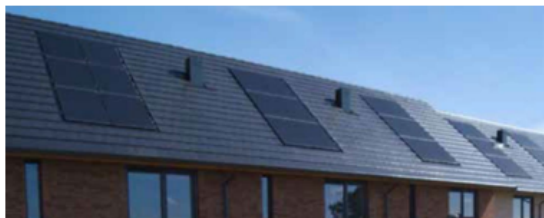
PV-cellen zoveel mogelijk in regelmatige, rechthoekige vlakken
