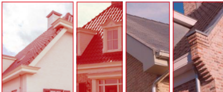
Zo niet: Geen uitgetimmerde bakgoten of dakoverstekken. Geen sierlijsten. Geen volkern materialen. Geen oren aan de gevel.
