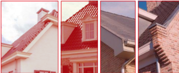
Zo niet: Geen uitgetimmerde bakgoten of dakoverstekken. Geen sierlijsten. Geen volkern materialen. Geen oren aan de gevel.
