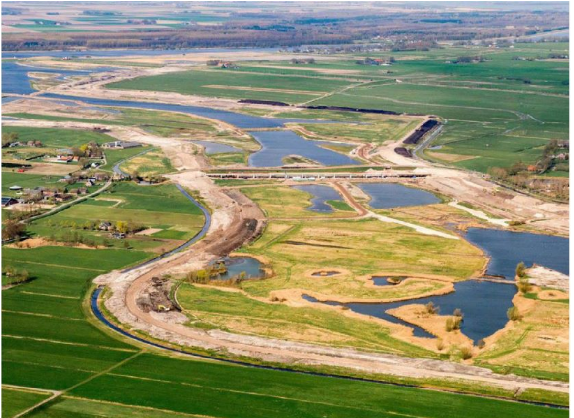
Het Reevediep en de klimaatdijk in aanleg
