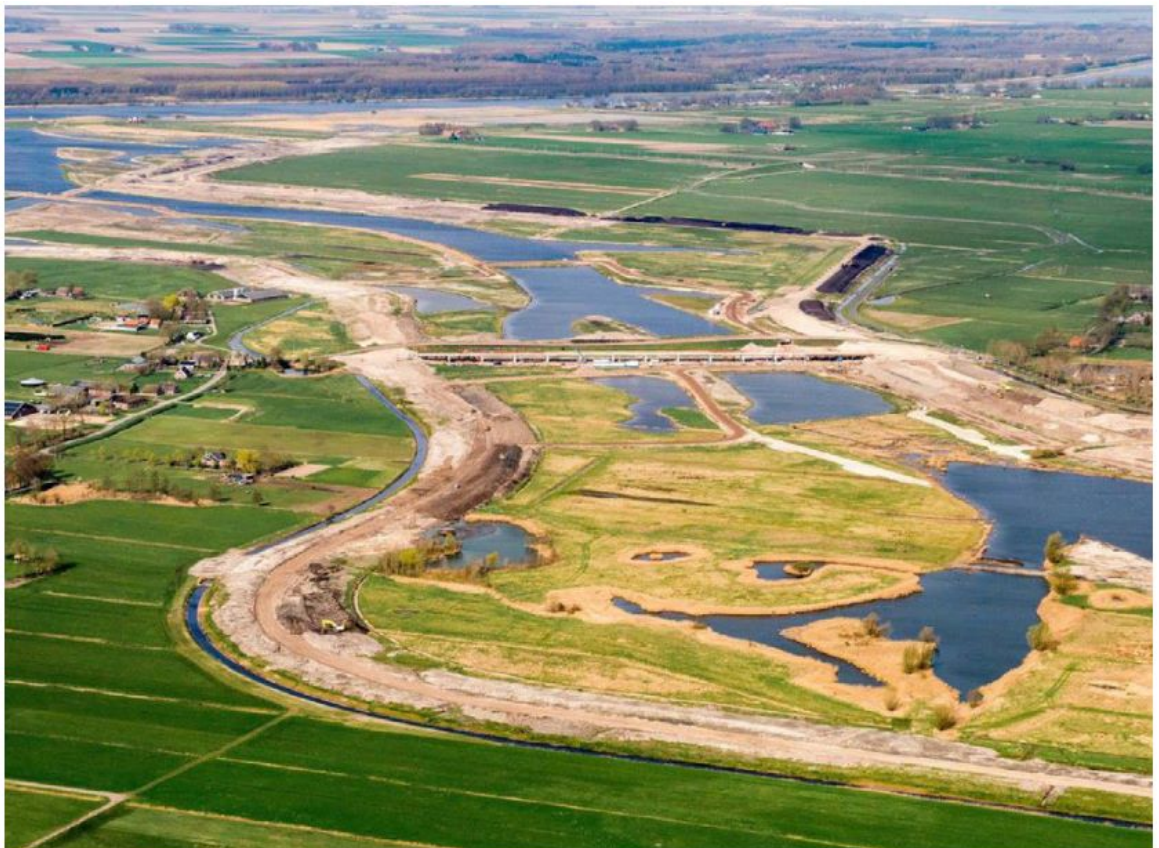
Het Reevediep en de klimaatdijk in aanleg
